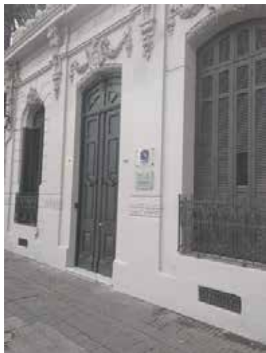
Figura 3: Fachada de la Casa de FLACSO Uruguay
